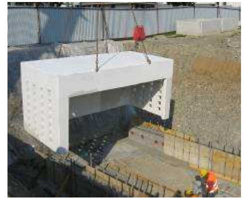
Posa elemento di testata SIS
