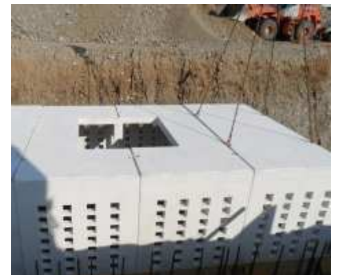
Fasi di montaggio
