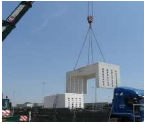
Fasi di movimentazione degli elementi
