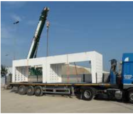
Arrivo dei manufatti SIS in cantiere
